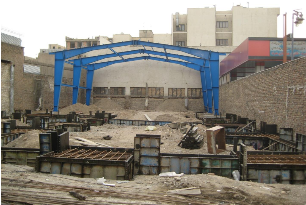
اجرای سوله بازیافت
