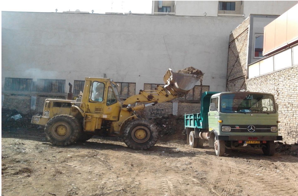
انجام عملیات پی کنی
